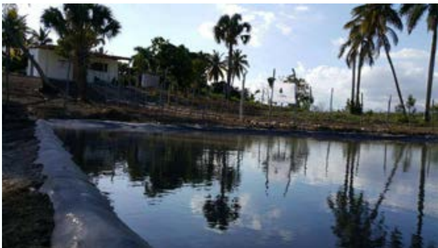
Proyecto en Gambia del español Pedro Tomás Delgado para potabilizar agua a bajo coste. Agua Inc
